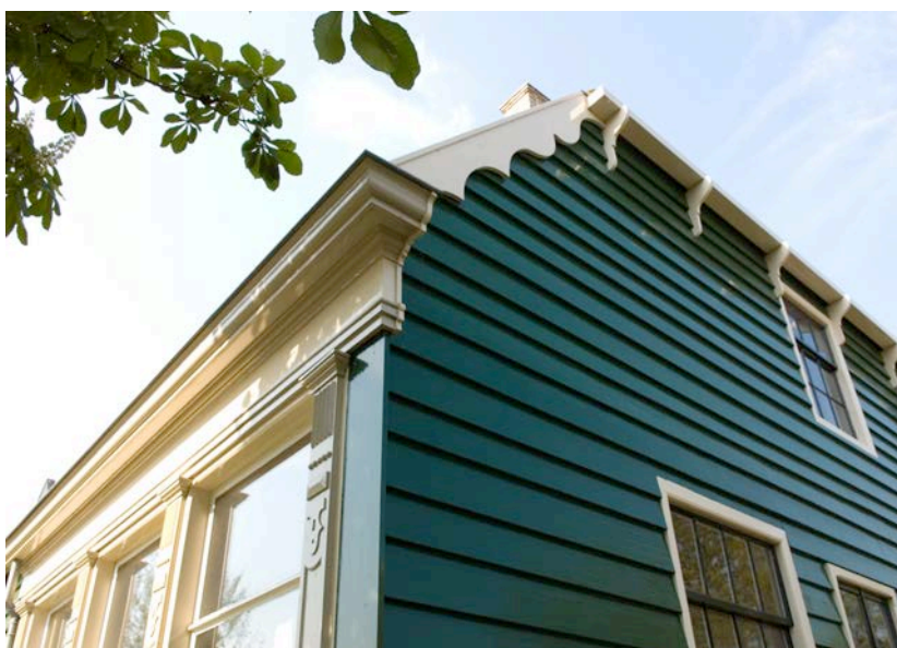
detail foto Lagedijk 7-9
